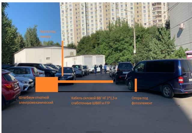
2.1. Тип шлагбаума: **Шлагбаум автоматический, откатной с электромеханическим приводом NICE RB 400.**
